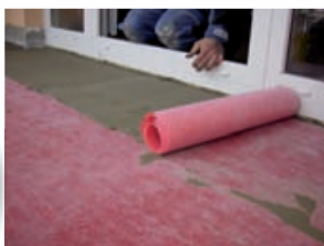
Do vrstvy lepidla pokládáme s přesahem 10 cm
