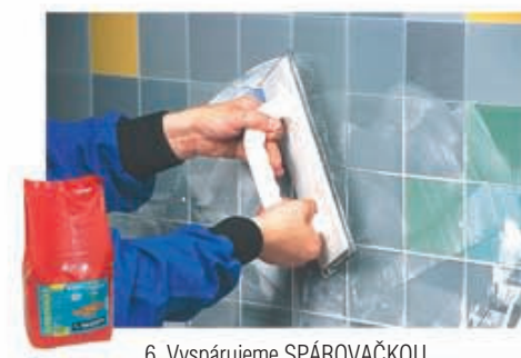
6. Vyspárujeme SPÁROVAČKOU
