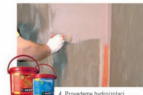
4. Provedeme hydroizolaci LEPENKOU V KÝBLU
